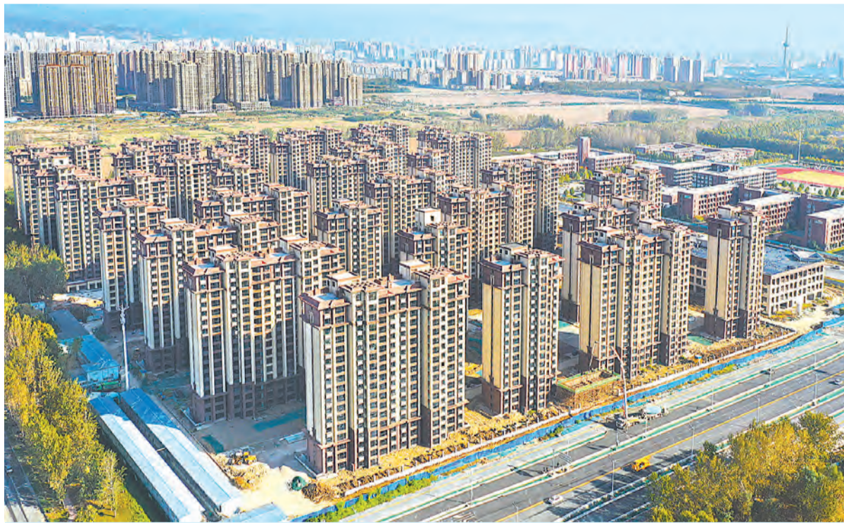
11月13日,高新区规划建设沁泉湖社区正在有序施工。作为城中村改造项目,高新区正在施工的鑫河社区一期项目的440套安置房和滨河社区一期项目的1260套安置房现已完工交付,沁泉湖社区的2600余套安置房正在进行室外配套施工,预计明年元旦前完工交付。 本报记者 刘金元 摄
